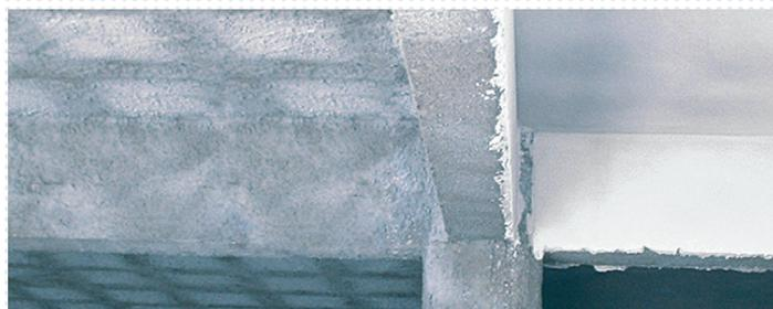
O chapisco pode ser feito com o traço 1:3 (cimento:areia), adicionado aditivo colante para argamassas. O aditivo deve ser diluído em água, conforme orientação do fabricante. Antes da aplicação do emboço, recomenda-se esperar a secagem do chapisco. A massa de emboço deve ser feita nos mesmos moldes tradicionais - 1:2:8 (cimento:cal:areia).
